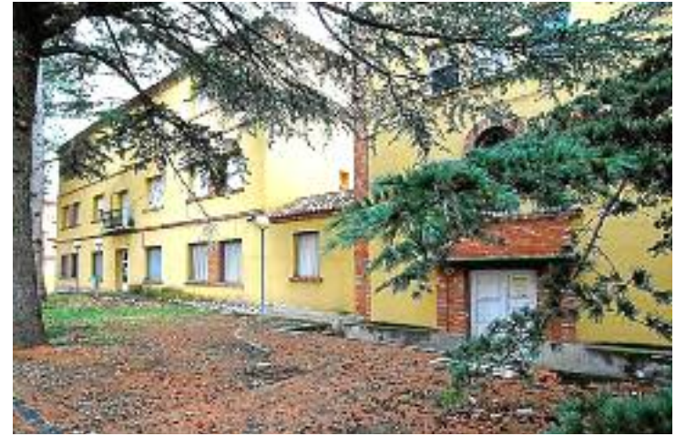
Edificio en el que se instalará la miniresidencia de Salud Mental Teruel
