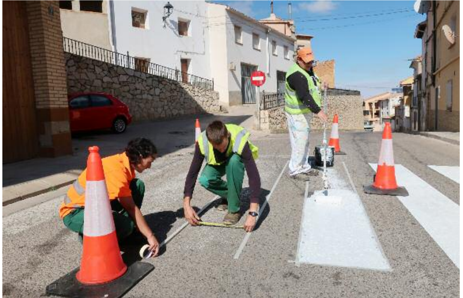
Trabajadores de ATADI Empleo llevan a cabo labores de señalización vial en una travesía
