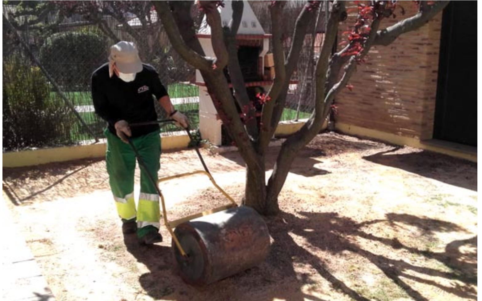
Un operario de Atadi Empleo prepara el suelo para instalar césped artificial
