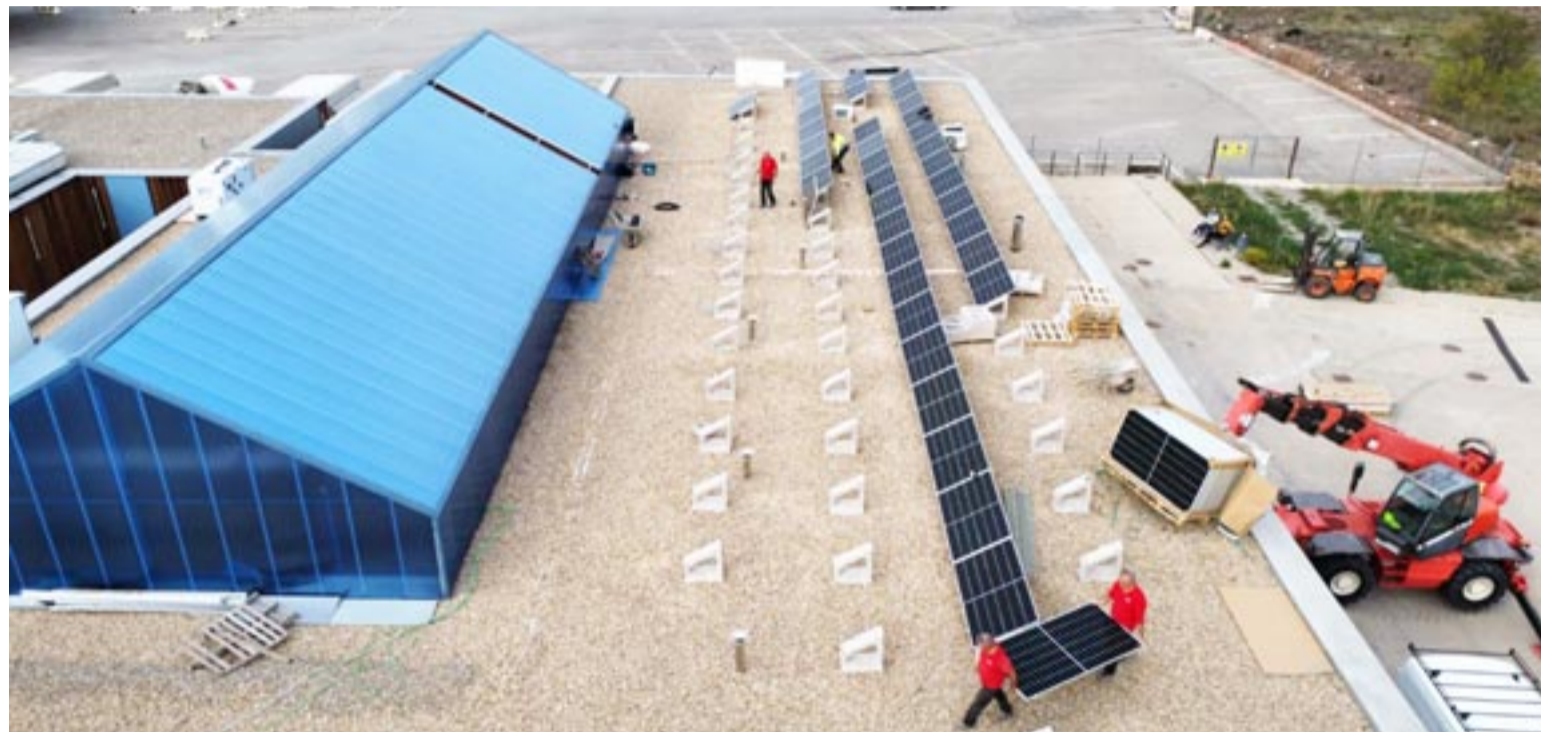
Instalación de placas fotovoltaicas en el tejado del centro Atadi Mora de Rubielos
